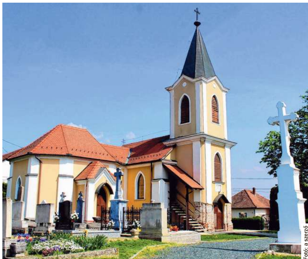
A templomot 1906-ban építették és 1993-ban bővítették, most a külső felújítása zajlik
